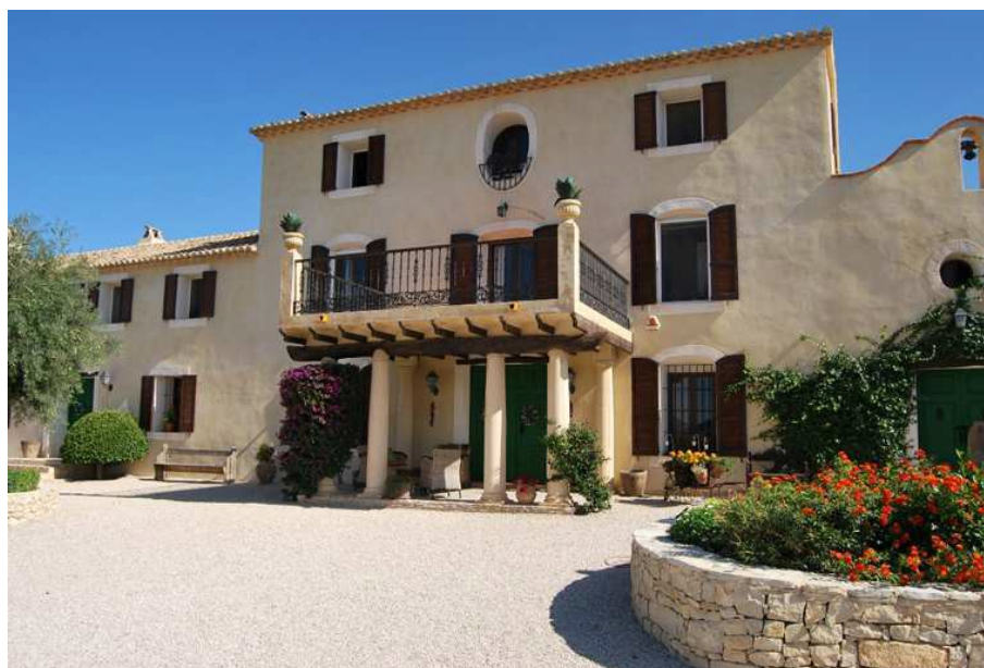
Vista de la casa (edificio principal)
