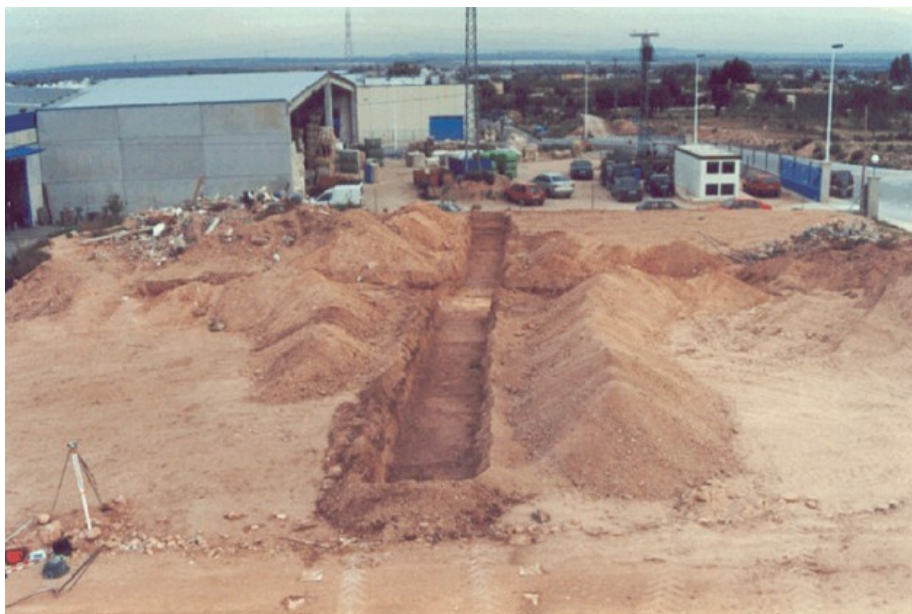
Vista general de la parcela con los sondeos efectuados
