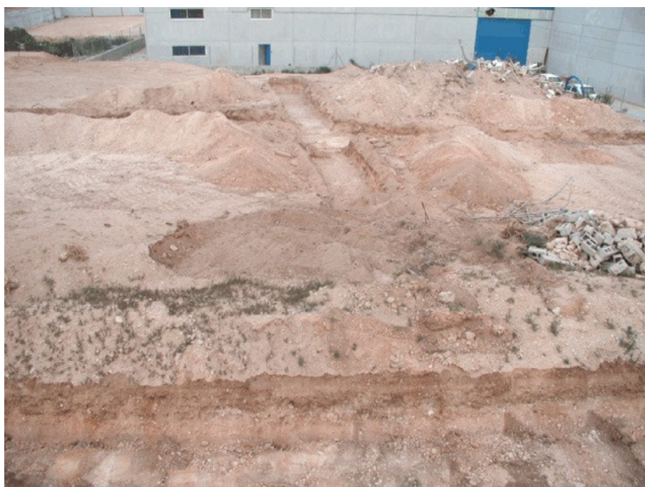
Vista general de la parcela con los sondeos efectuados
