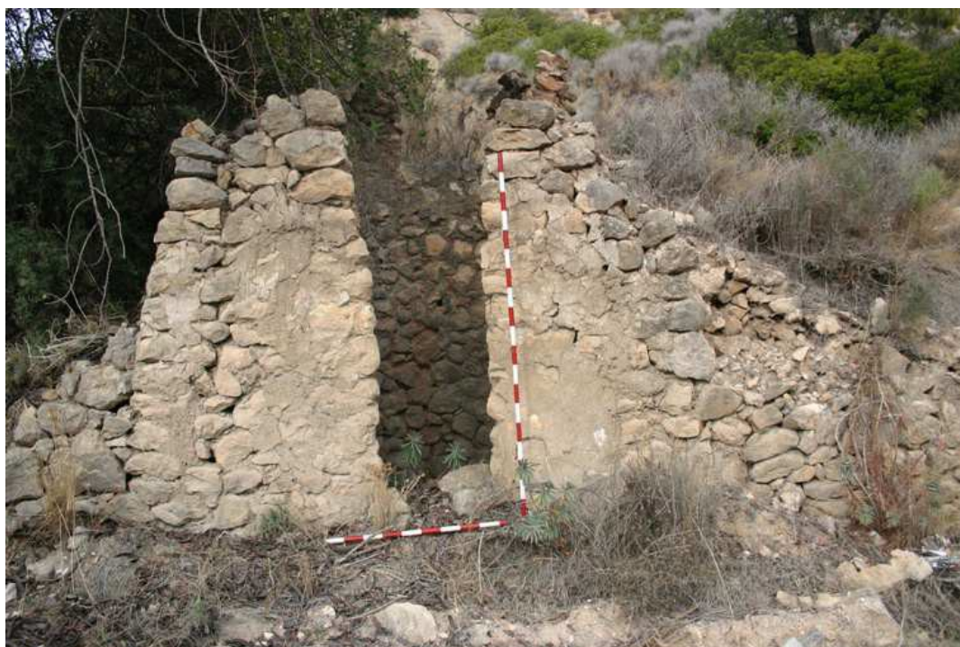
Pozo 2 desde el este
