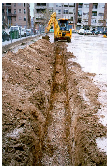
Zanja de sondeo
