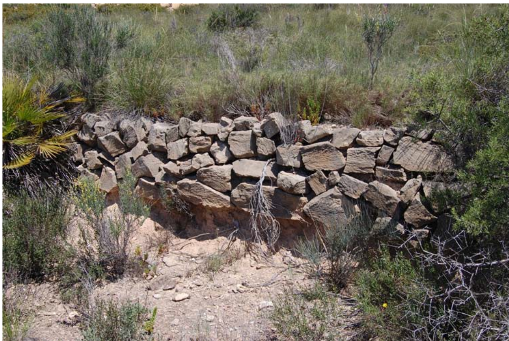
Ribazo de abancalamiento en la parcela 251 del polígono 5 de El Campello
