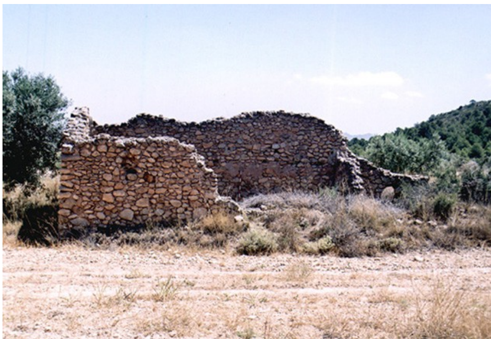
Vivienda agrícola parcialmente afectada por el embalse de La Boquera
