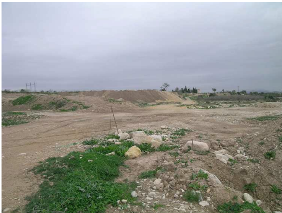
Otra vista de la zona de la EDAR
