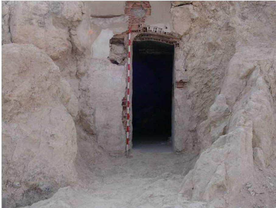
Acceso al nido de ametralladora
