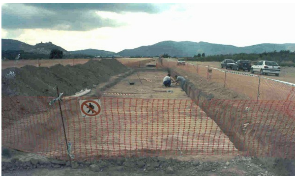
Vista general de la excavación
