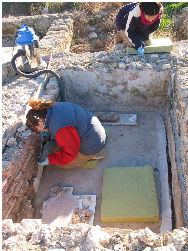
Consolidación de revestimientos en una balsa de la zona termal
