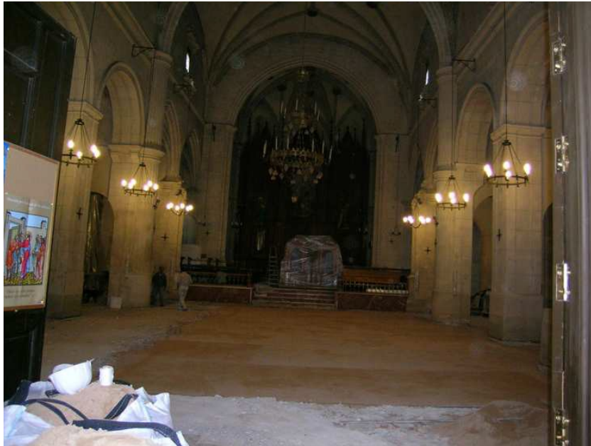
Vista de las obras en la nave central desde los pies de la iglesia
