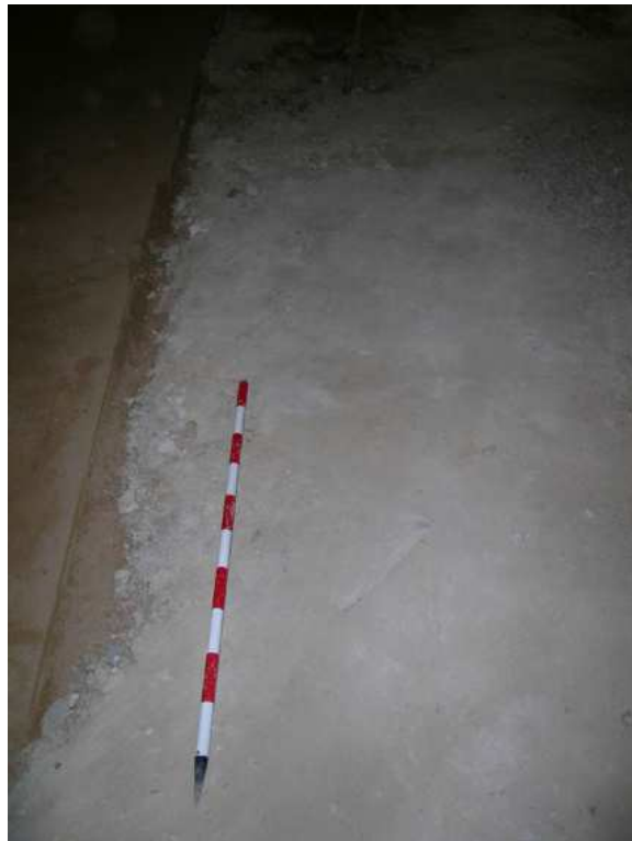
Detalle del pavimento antiguo
