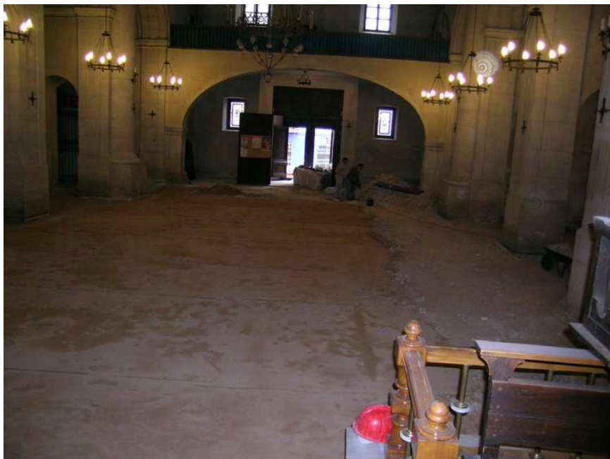
Vista de las obras en la nave central desde el altar
