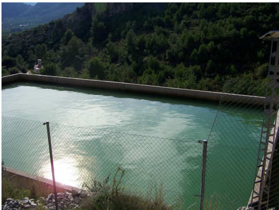
Vista de l'actual dipòsit
