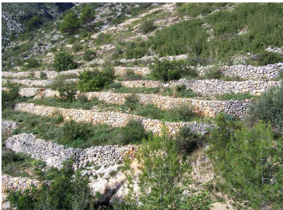
Vista dels aterracaments
