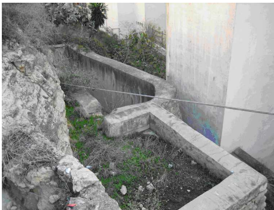
Vista general de las balsas
