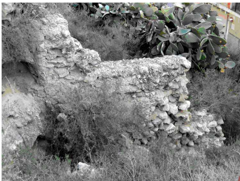
Estructura de encofrado
