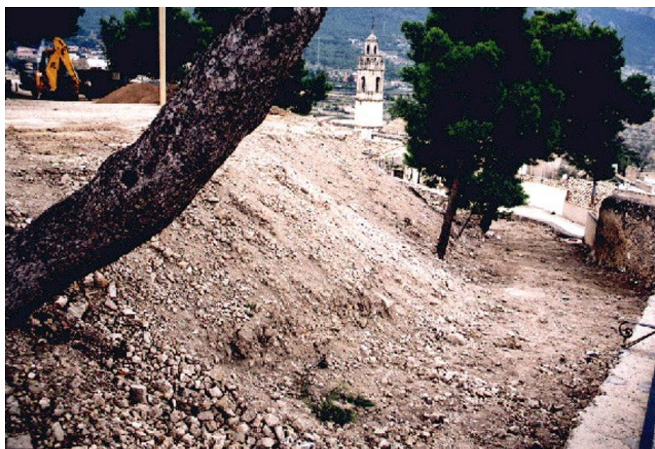
Desmonte de la terrera para colocar la escalinata
