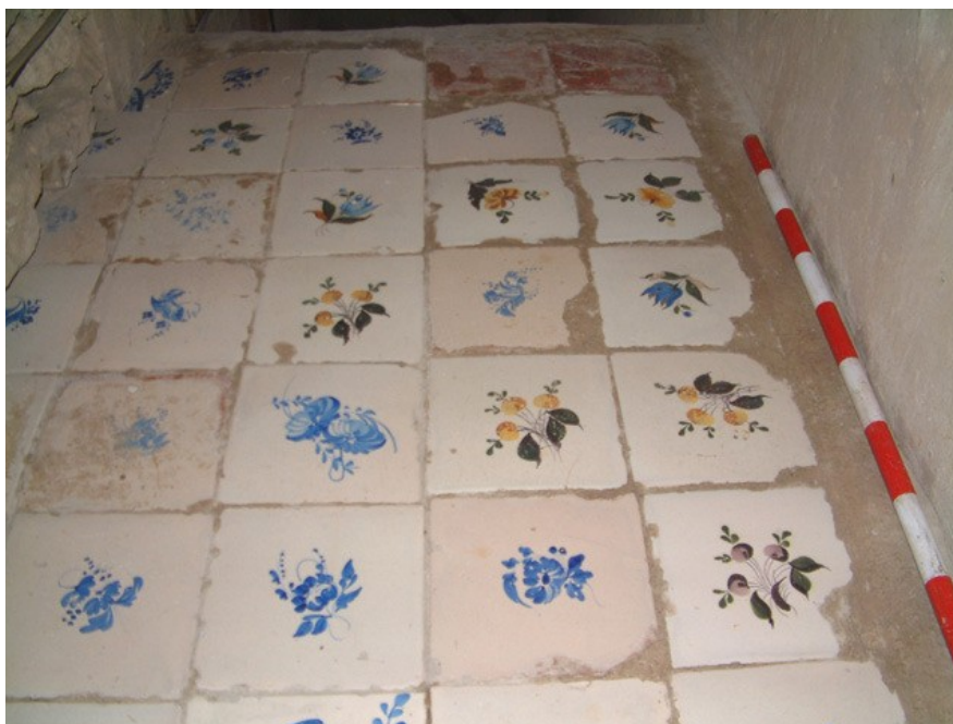
Pavimento de azulejos del camarín del altar mayor
