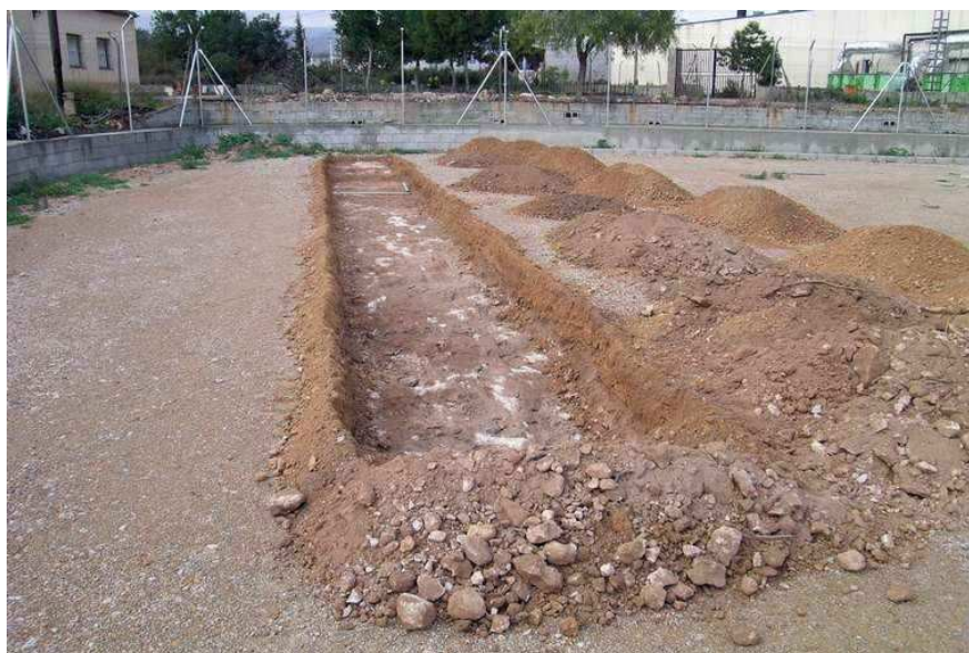
Vista de la zanja
