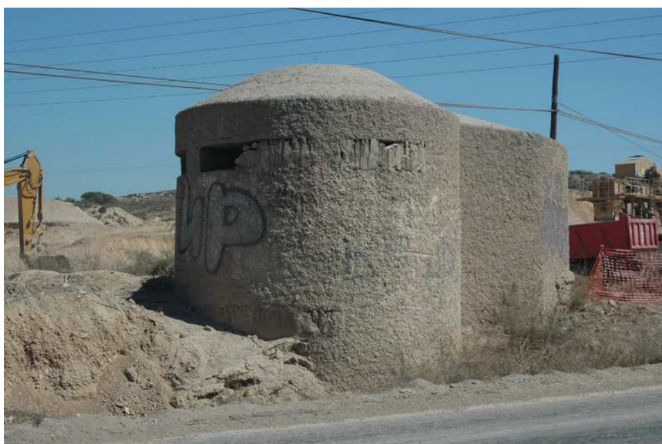
Vista del búnker
