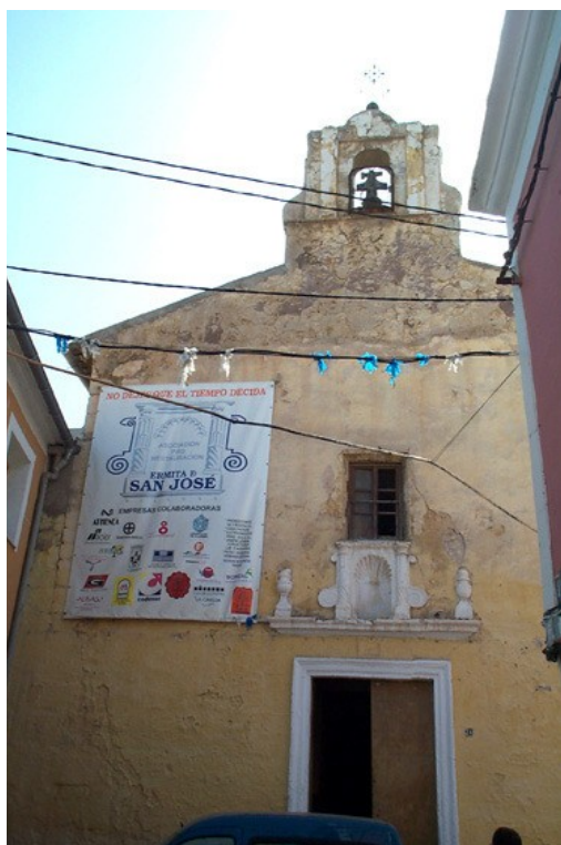
Fachada ermita antes de su restauración
