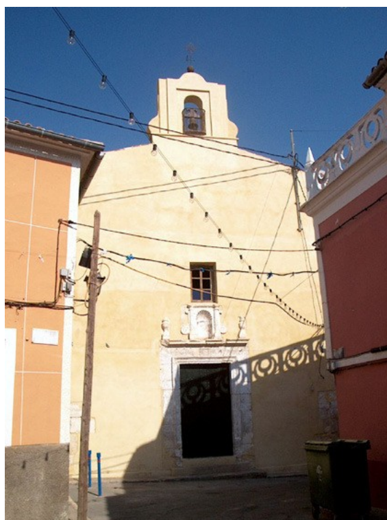
Fachada ermita tras su restauración
