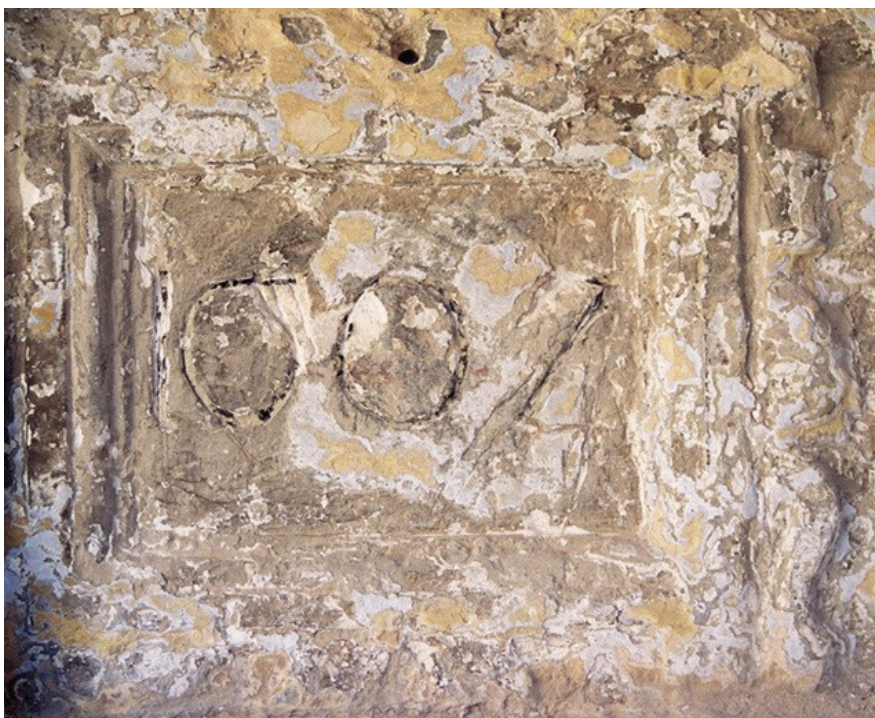
En la portada, bajo capas encaladas apareció la fecha de edificación de la ermita: 1607
