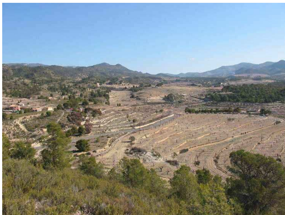
Vista de la zona final del trazado de la carretera CV-780
