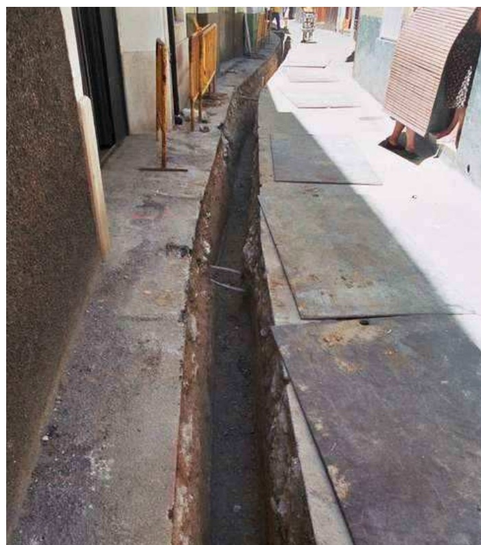
Final de zanja en calle Baja
