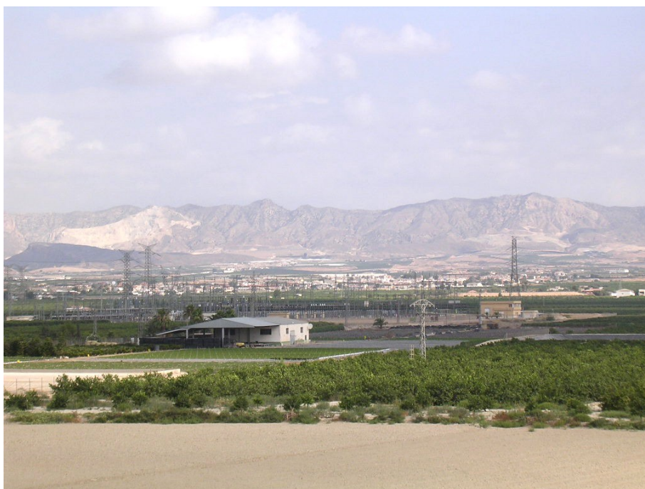
Vista de la subestación eléctrica
