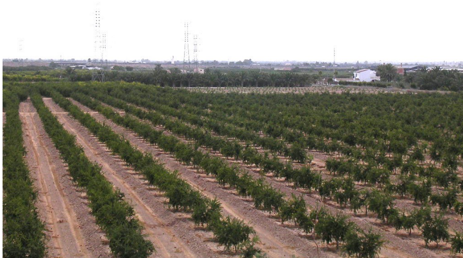
Vista de los bancales por donde discurrirá la línea eléctrica
