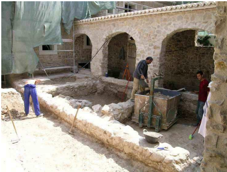
Proceso excavación patio
