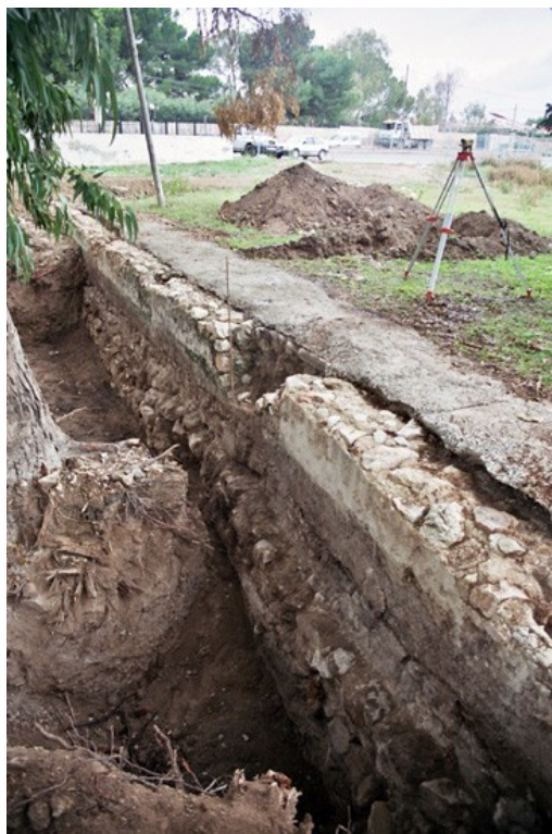
Zapata y alzado azud
