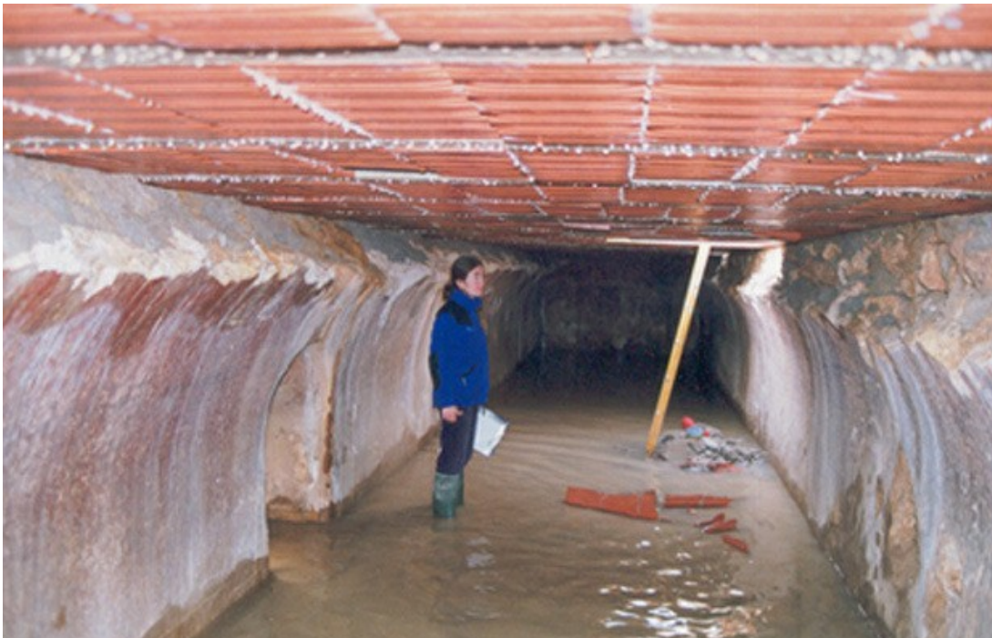
Interior del aljibe
