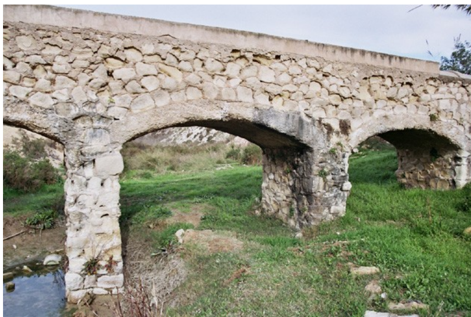
Detalle del acueducto con los arcos encofrados en mortero de cal
