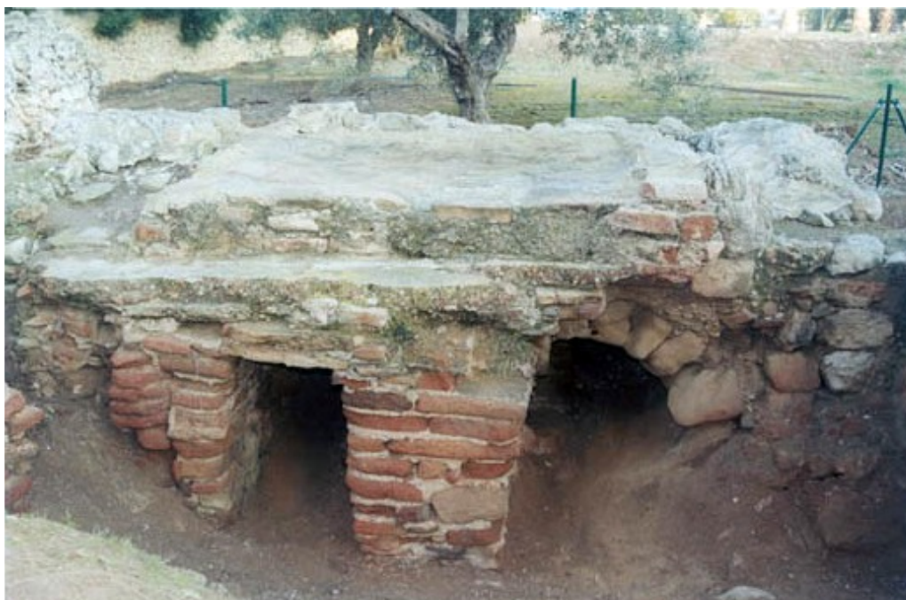
Tepidarium tras los trabajos de limpieza
