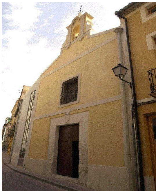
Fachada principal de la ermita de San Antón
