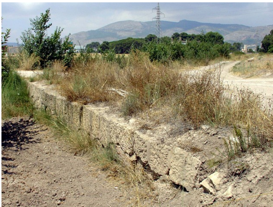
Estructura de sillares en el barranco en el Sector 2
