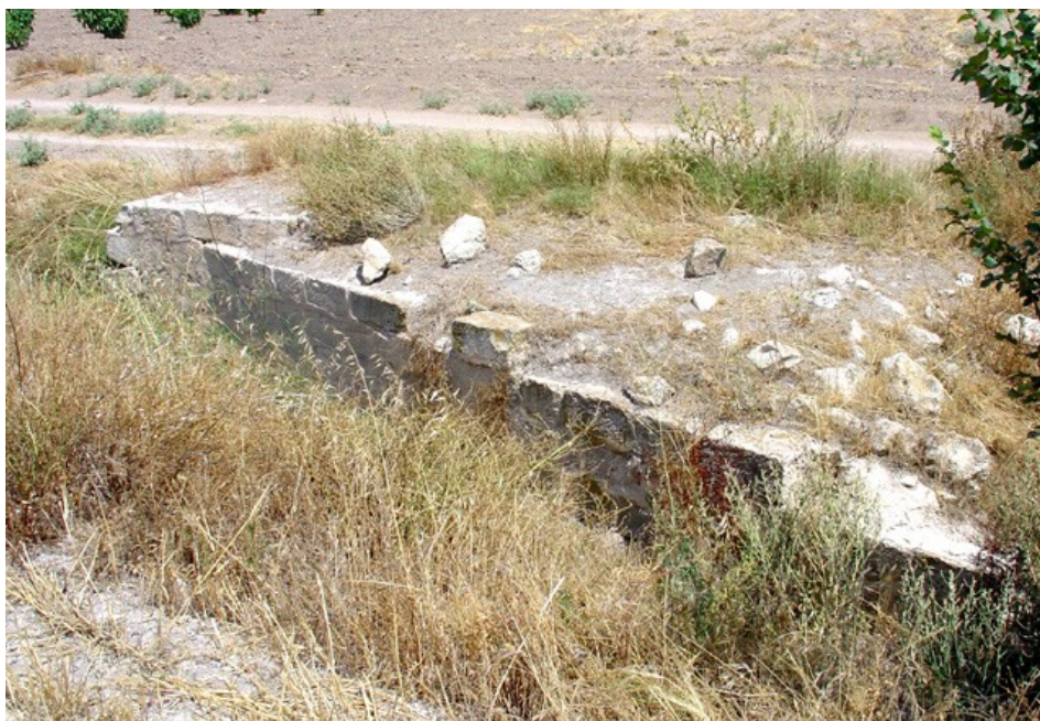
Detalle estructura de sillares en el barranco en el Sector 2
