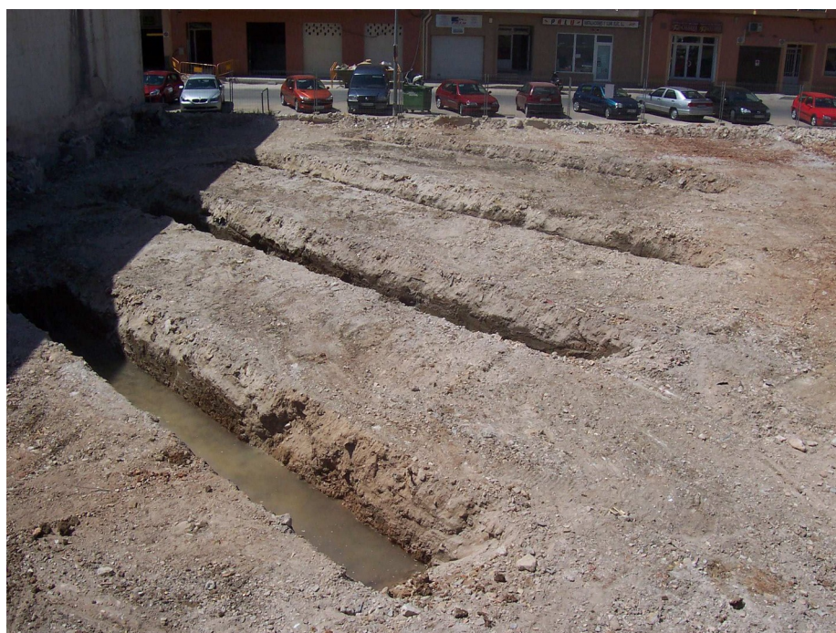
Vista aérea zona oeste del solar, zanjas n.º 6, 5, 4 y 3
