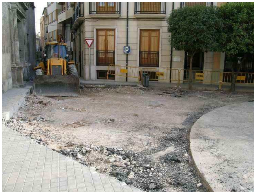
Vista del Sondeo I
