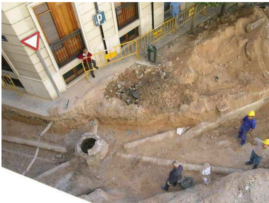
Sondeo I. Detalle de las canalizaciones
