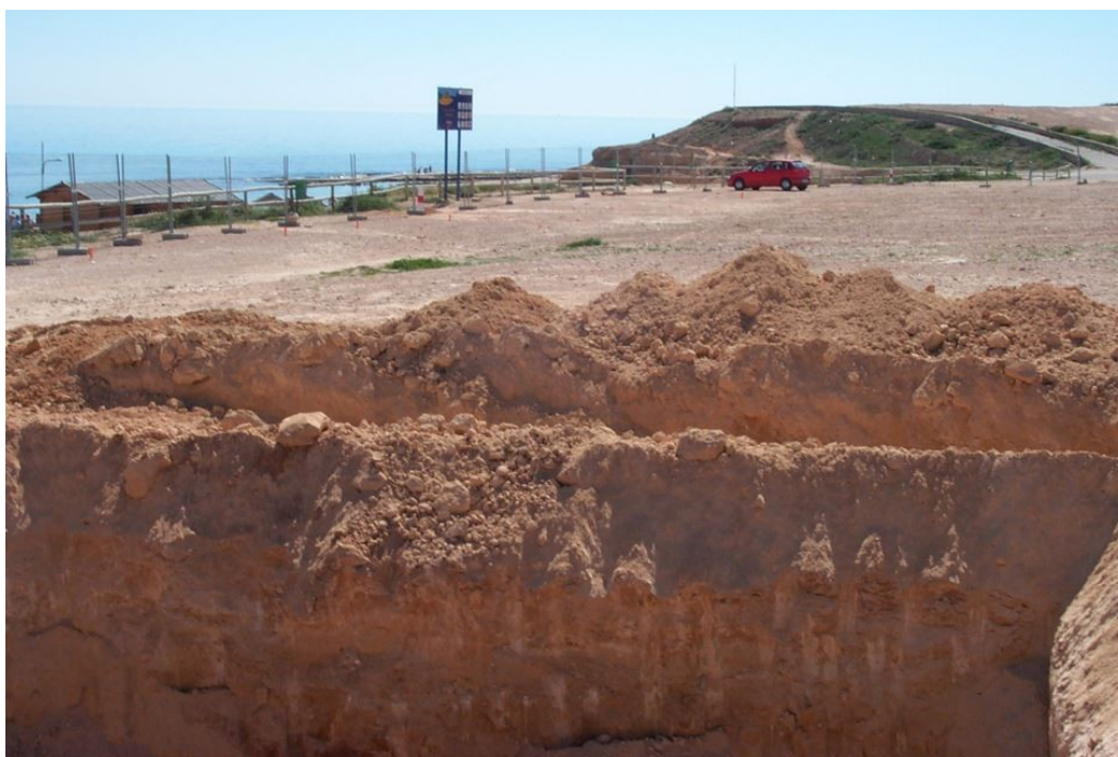
Pozo realizado en el río Seco
