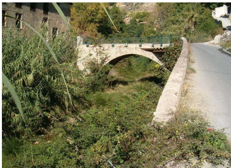
Puente Cadiseño y fábricas en la margen izquierda. Elementos n.º 9 y 13
