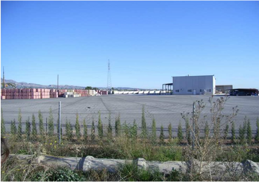
Vista de la zona construida de la parcela
