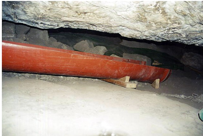
Vista del tubo para acondicionamiento interno de la cueva
