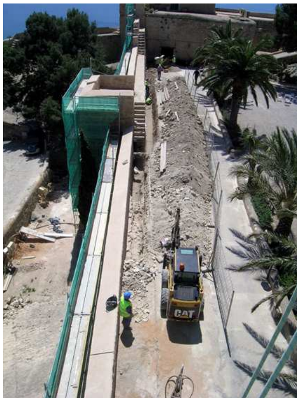
Vista de la trinchera de saneamiento paralela al Albacar d'Enmig
