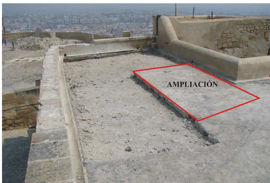
Vista del área de actuación llevada a cabo en la Casa del Gobernador
