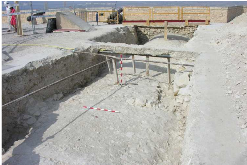
Vista de la Sala Larga al final de la intervención. Se observa el trasdós de la bóveda
