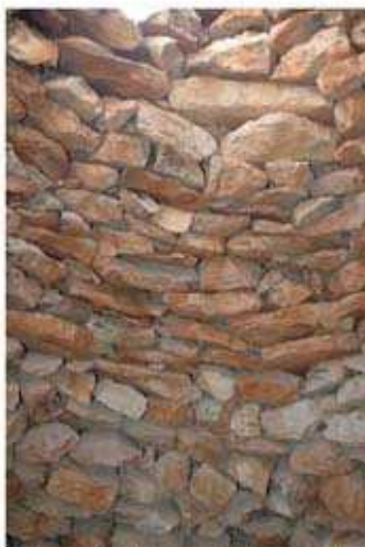
Fig. 4: Cubierta con falsa cúpula.
