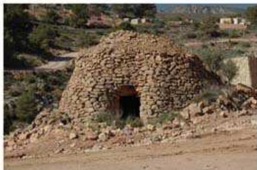
Fig. 1: Vista frontal (S) del inmueble.
