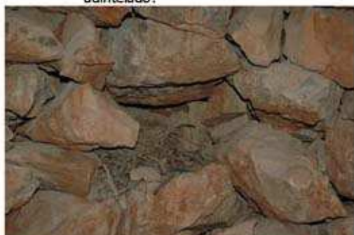
Fig. 6: Detalle oquedad en el interior del cuco
