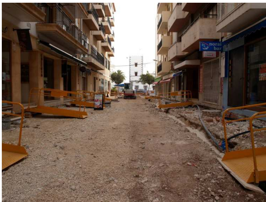
Carrer Lambert a la finalització dels treballs
