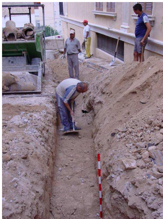
Limpieza de la zanja en la calle San Bonifacio
