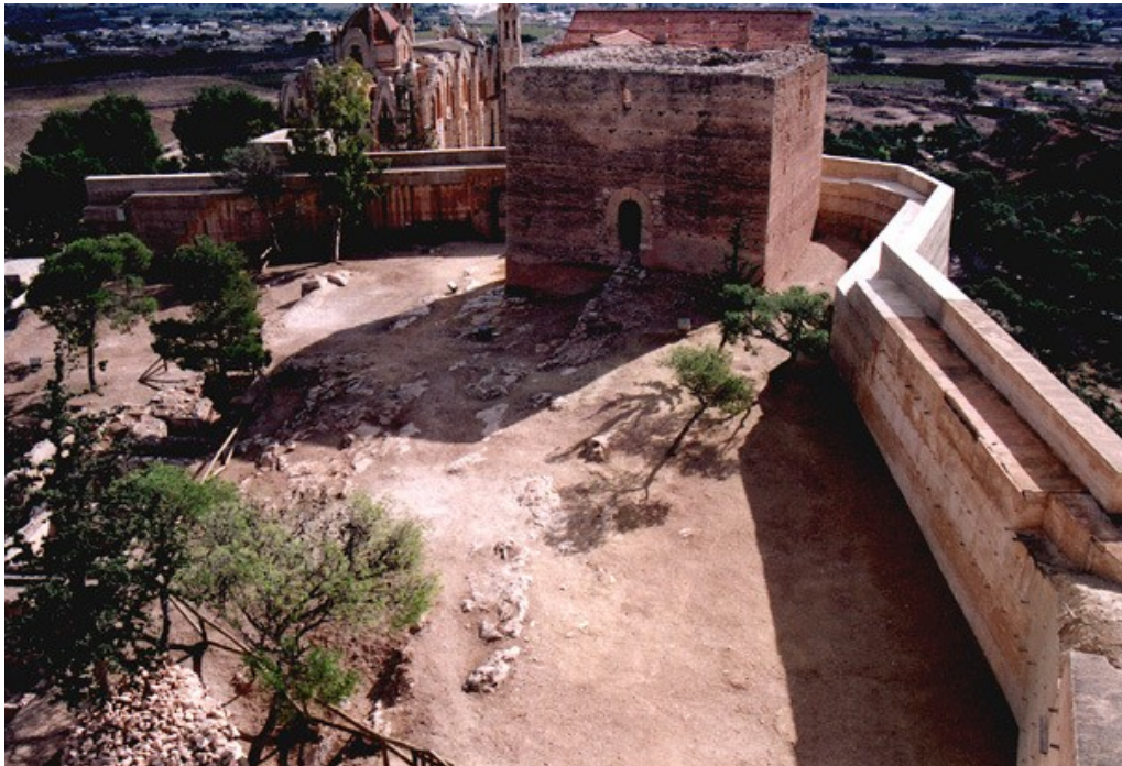
Estado final del interior tras los trabajos de limpieza
