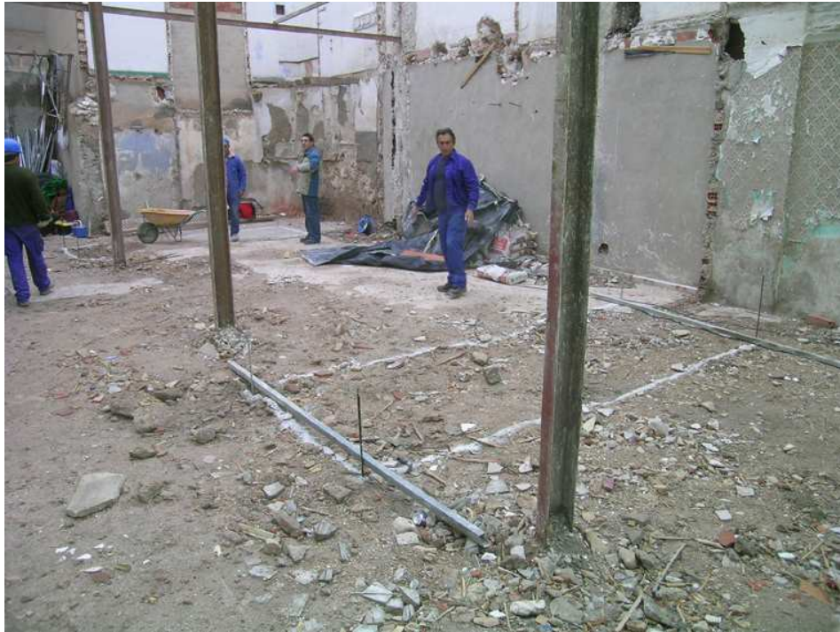
Situación del área de excavación
