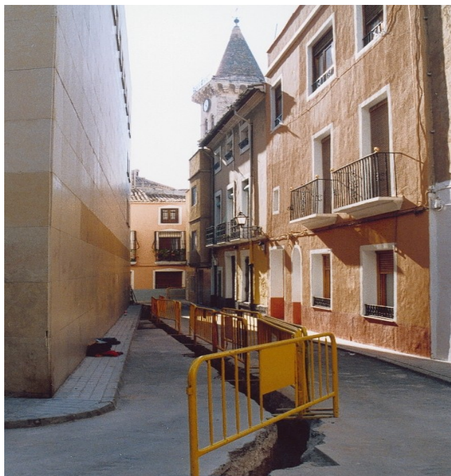
Trazado de las zanjas en la calle Oscar Esplá
