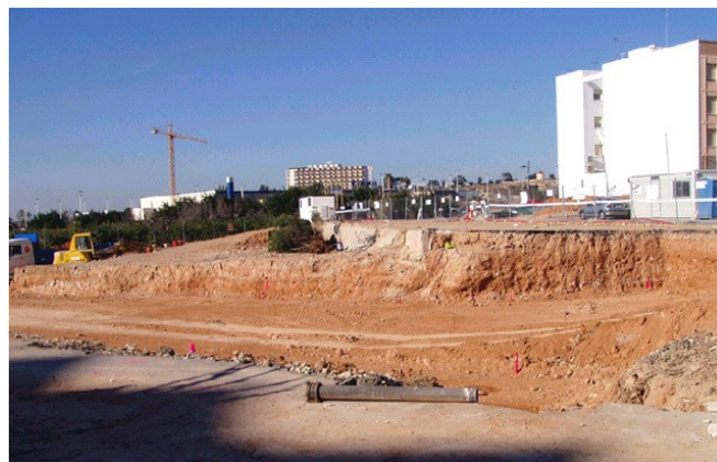
Vista general del solar
