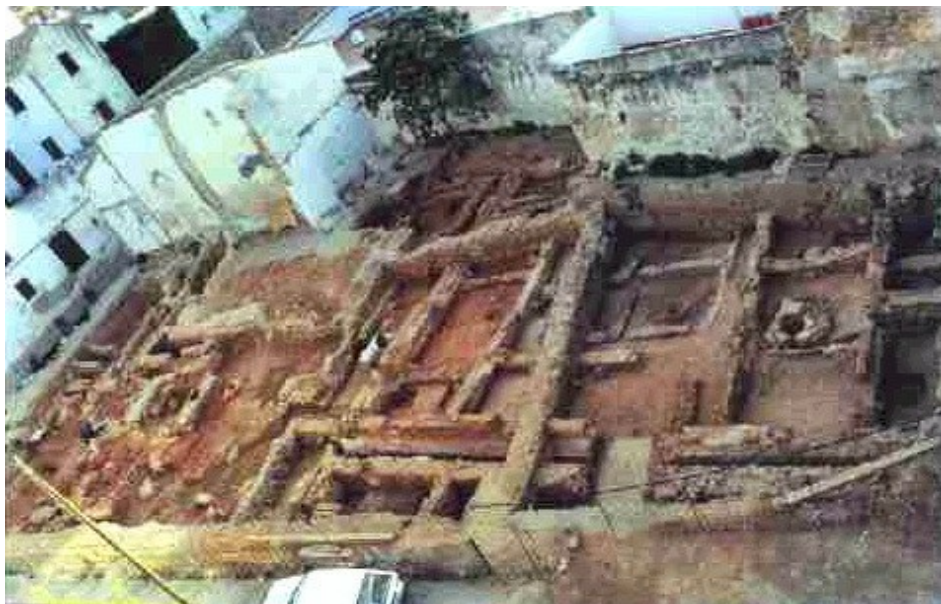
Vista general de la excavación
