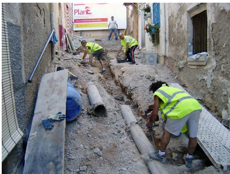
Extracción y sustitución del alcantarillado de la calle Jesús el Vicari
