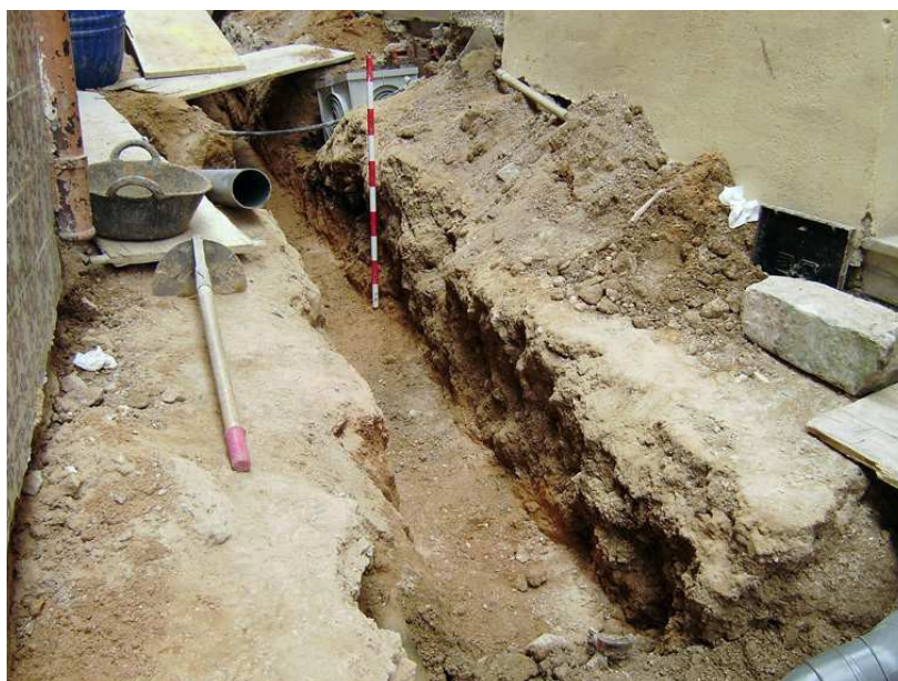
Zanja para la sustitución del alcantarillado de la calle Jesús el Vicari
