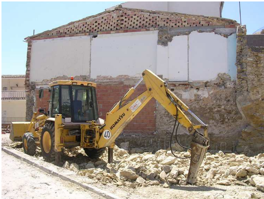
Proceso de rebaje del subsuelo. La roca aparece en todo el solar
