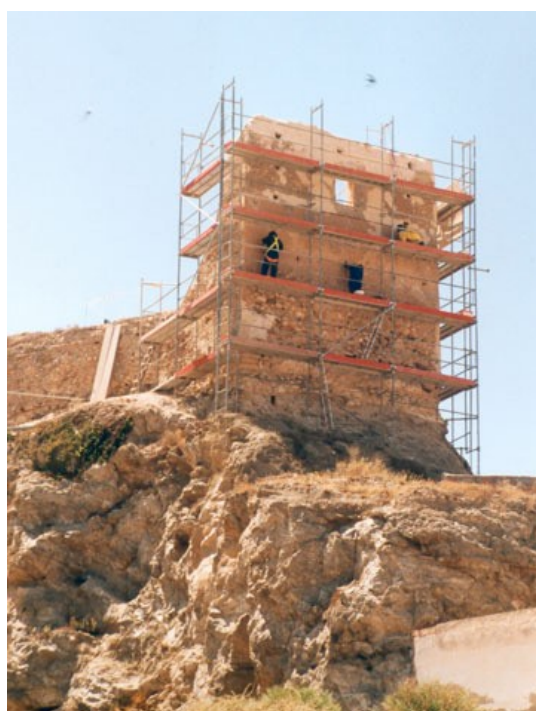
La instalación de un andamiaje especial fue necesaria para el acceso a las fachadas de la torre
