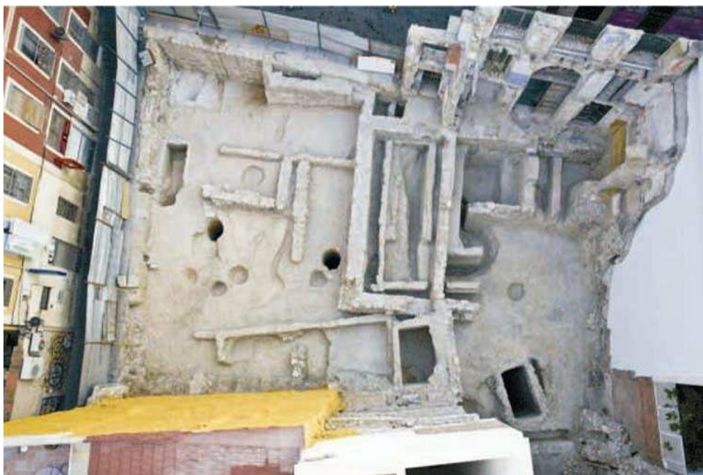
Vista aérea del final de la excavación
