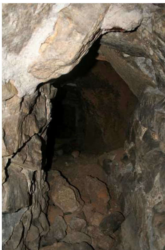
Vista interior de la canalización
