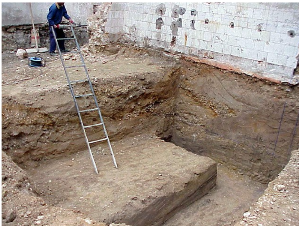
Rases de cimentació de la casa núm. 10 del carrer Sant Blai
